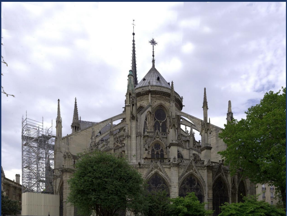
Das Gerüst richtet sich ein und steigt, hier am 8. April 2018, den Strebepfeilern entlang vor dem Chor an der Südfassade hoch.
